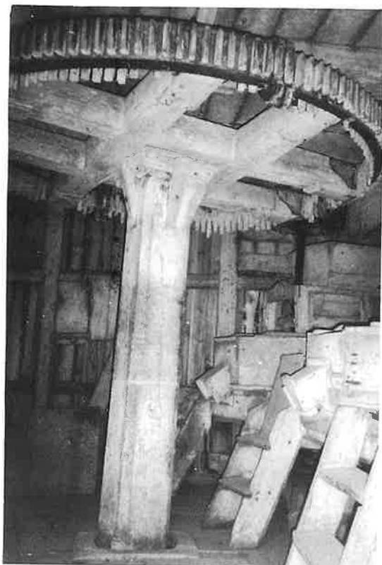
Fig. 48. Mølleakselen på 31 x 31 cm forbinder vannhjulet under mølla med det store tannhjulet som driver kvernene. Tannhjulet har 152 tenner av eik som er kilt fast i tannkransen av støpejern.
