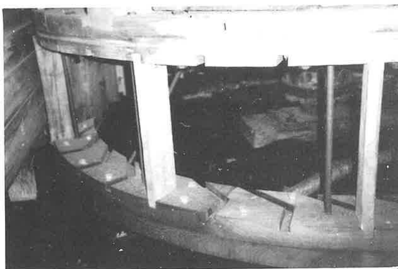
Fig.24. Vannhjulet er under reparasjon. Det meste av hjulkransen er skiftet ut. De to ringene holdes sammen av jernbolter. Nye skovler settes inn i utfresede spor.
