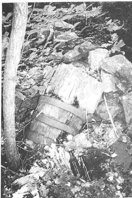
Fig. 50. Deler av akselen på vannhjulet ligger enda i muren etter mølla på Østre Vallesverd. Akselen er ca. 50 cm x 50 cm.
