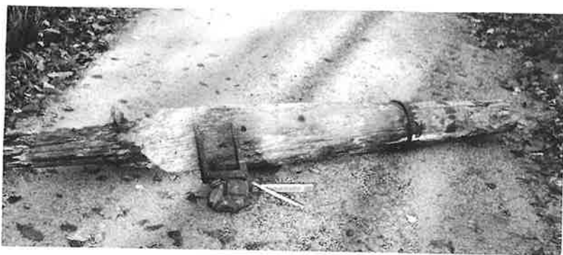
Fig. 22. Kallstokk og bunnlager fra den gamle kvernkallen.
