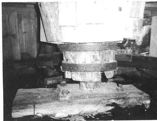
Fig. 36. Bunnsugga. Den kraftige akselen på vannhjulet står i et lager av støpejern.
