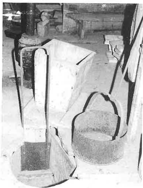
Fig. 26. Grynsteinen mates gjennom trakta. Kornet hentes opp ved at spannet settes ned i hullet i forgrunnen på bildet.
